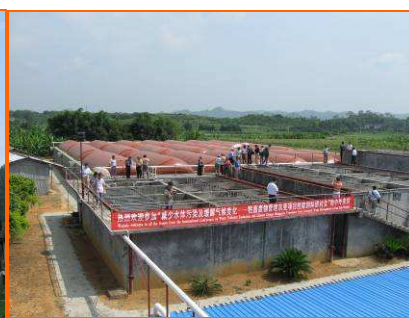
Colocación de Cubierta plástica
