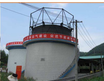
Digestor y gasómetro en cemento
